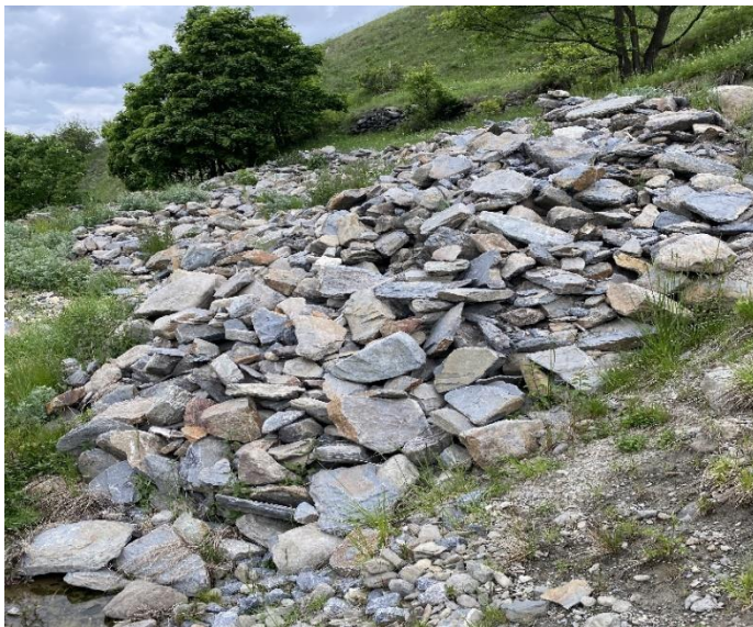
Stockage pierres de murs : (Plus de 1000t ! sur une plateforme de 400 m²)
