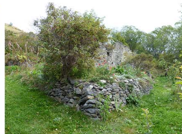
MURET DE SOUTIEN EN PIERRES POUR LE POTAGER SOUS CHALET TROCCAZ
