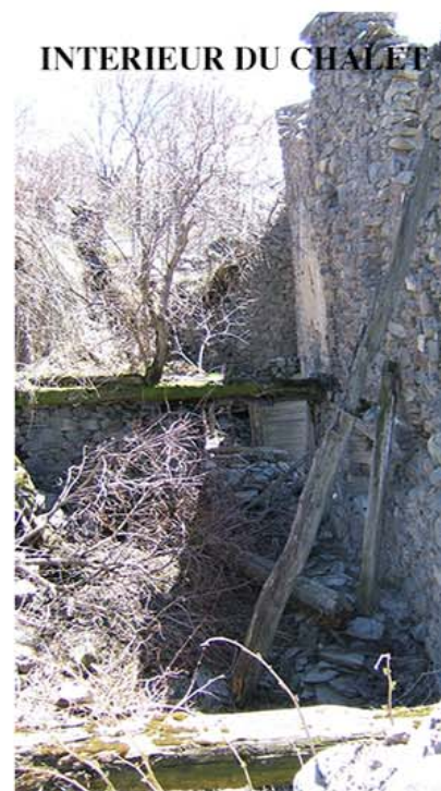
PRESENCE D'ENDUIT A L'INTERIEUR DU LOGEMENT
