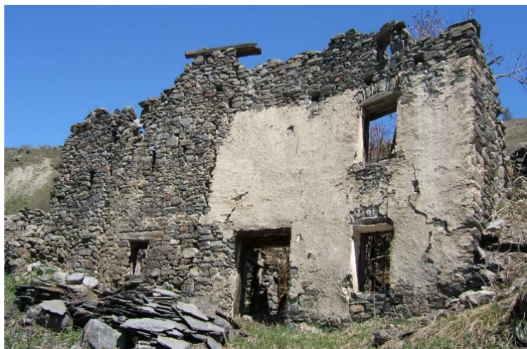
Façade en Mai 2016
